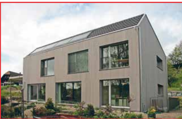
Die grossen Fensterflächen auf der Südseite tragen viel zur Heizenergie bei. (Foto: Stéphane Fresse)
