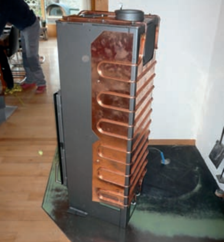
Der neue T-Loft Plus. Die Kupferbleche des Absorbers sind im hinteren Teil angebracht.
