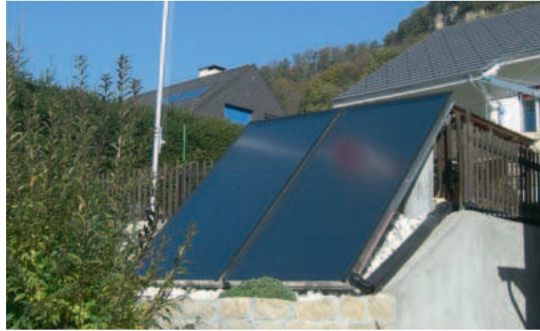
Kollektoren optimal ausgerichtet an einem Abhang im Garten montiert.
