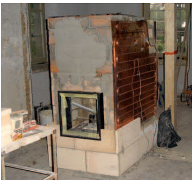
Zweischaliger Aufbau mit eingesetztem Absorber.
