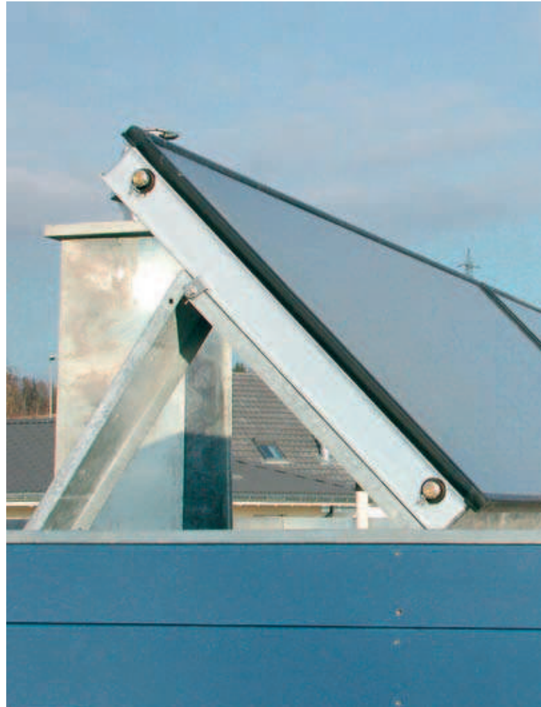
Kollektorenmontage auf einem Flachdach
