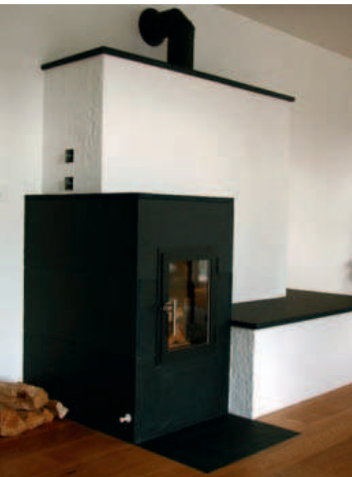
Kubischer Absorberofen verputzt, mit schwarzem Schiefer kombiniert.
