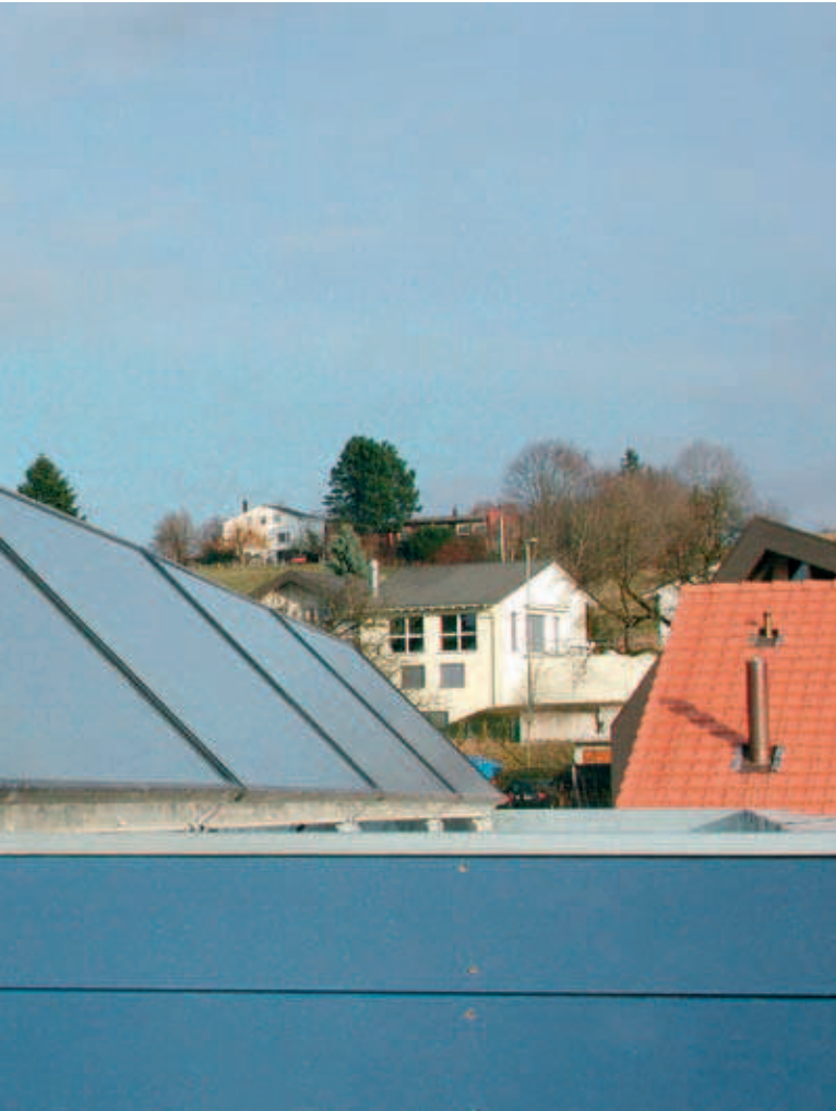
Kollektoren optimal ausgerichtet an einem Abhang im Garten montiert.
